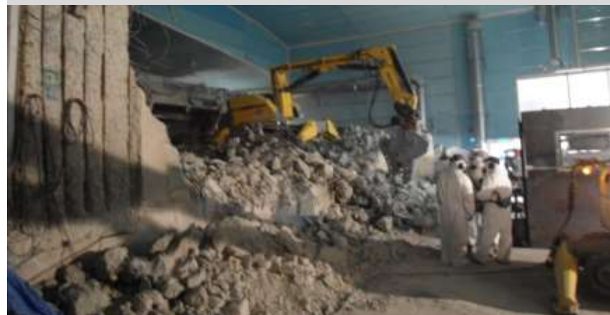
Station de traitement des effluents Démolition des structures Assainissement des sols
